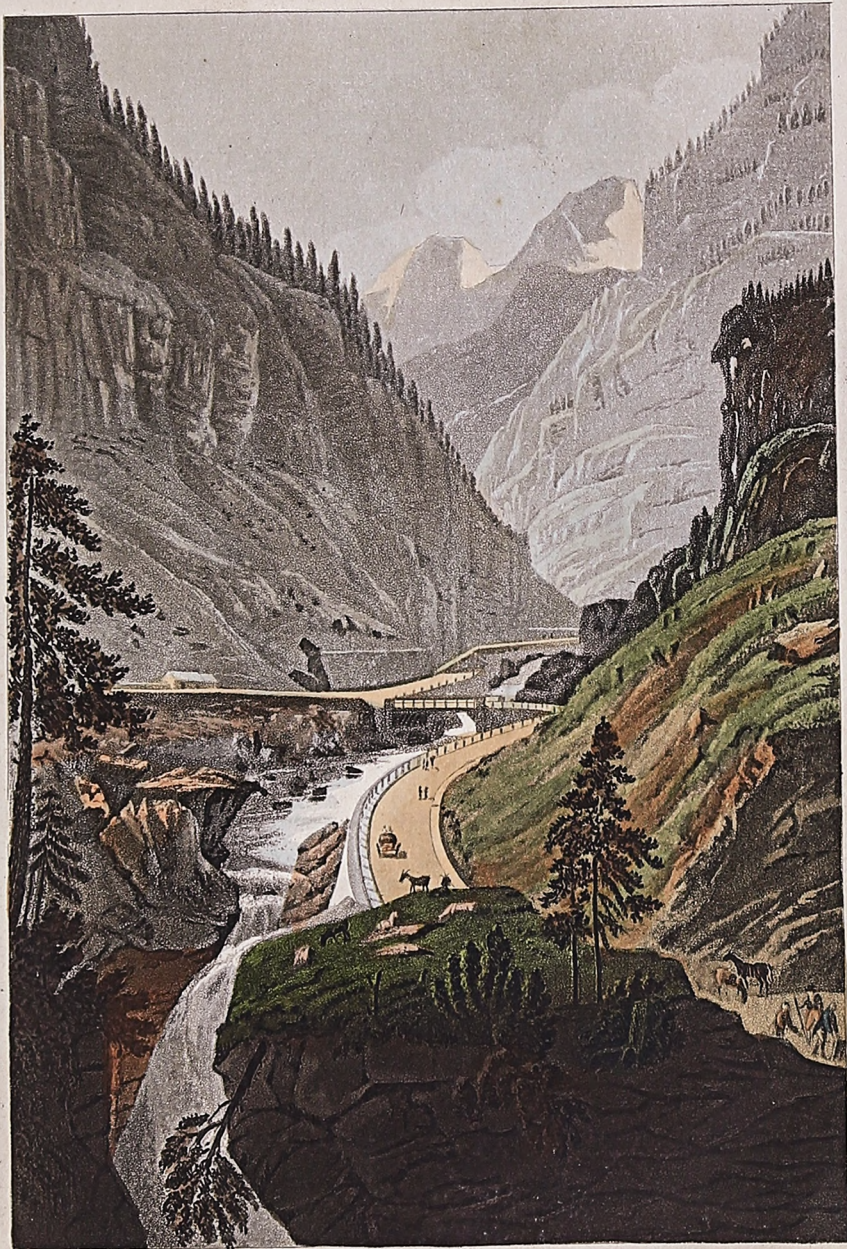
CAMINO NUEVO, de la GRAN GALERIA del SIMPLON.
