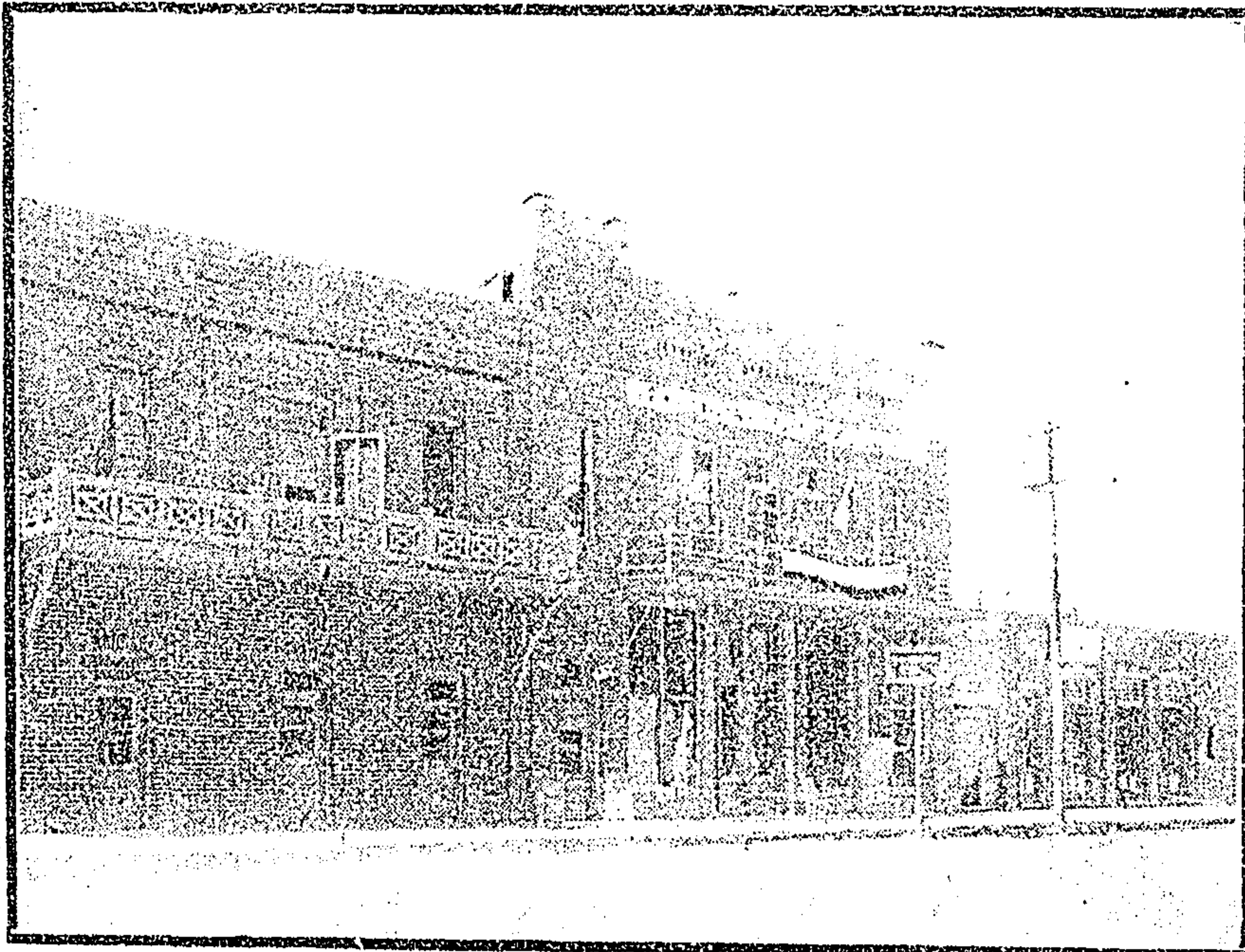
Edificio en donde fué instalado el Hospital de la "Cruz Blanca," en Ciudad Juárez.
