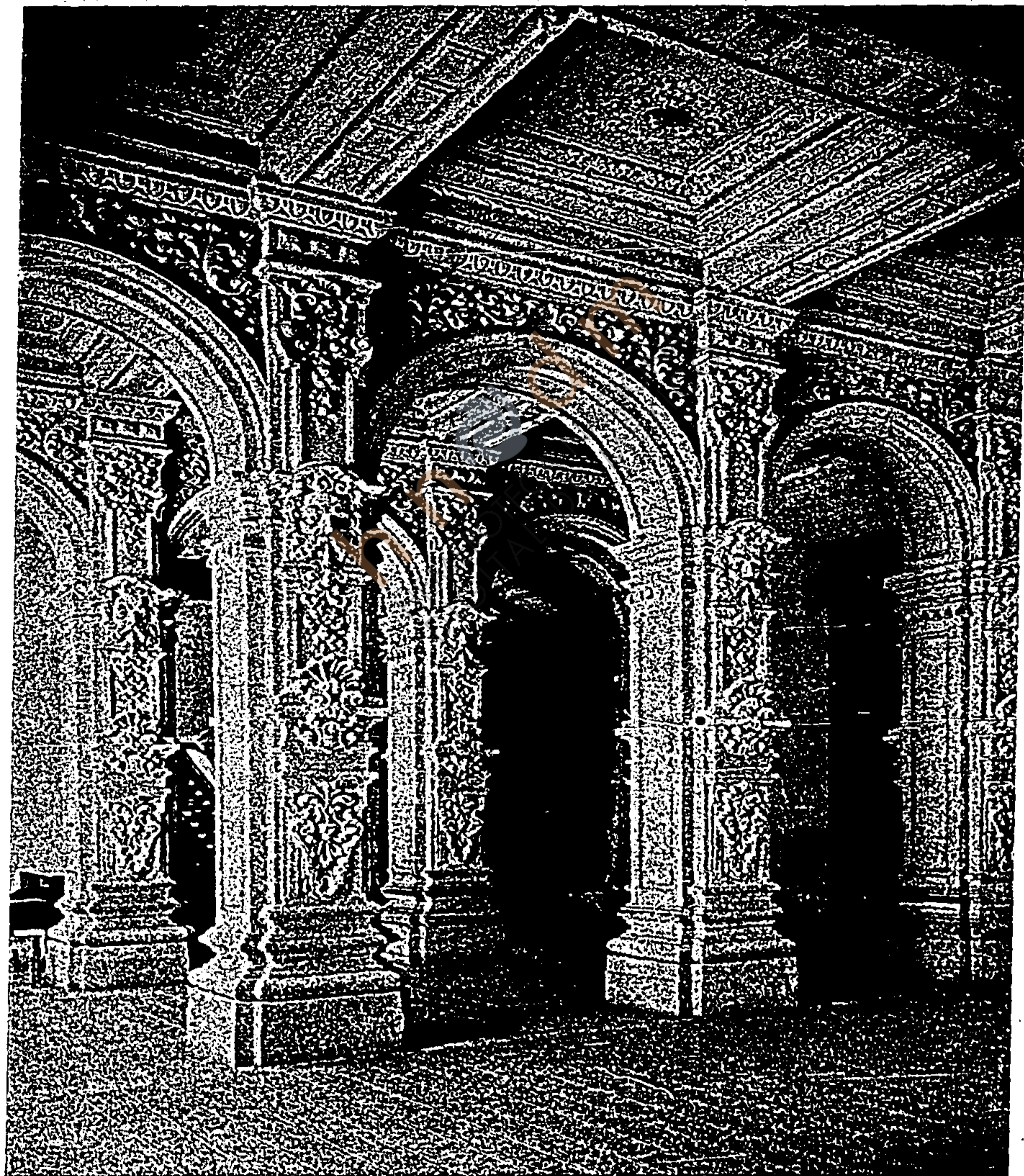
Un detalle de las obras de ampliación de la Escuela Nacional Preparatoria
